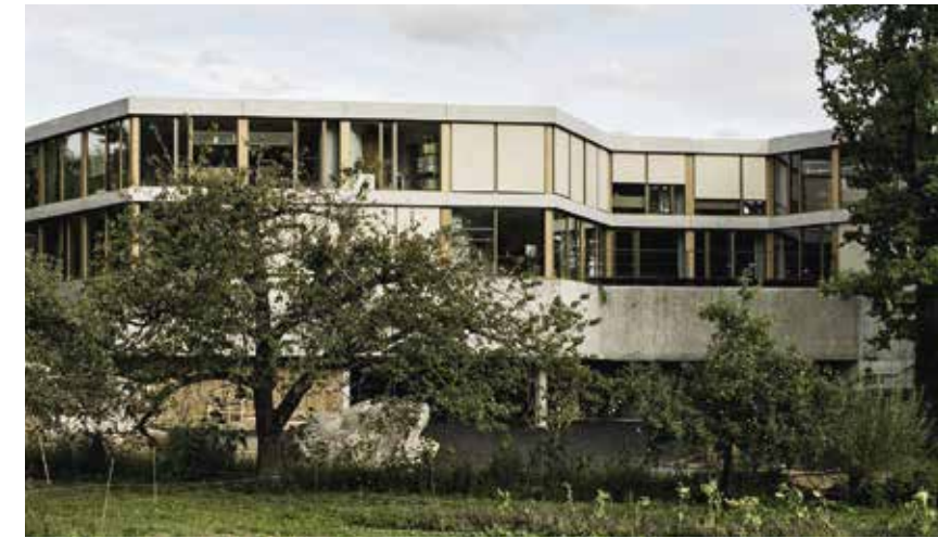
Gegen aussen ergibt die so bespielte Fassade ein lebendiges Bild innerhalb des ruhigen Haupttrasters.
