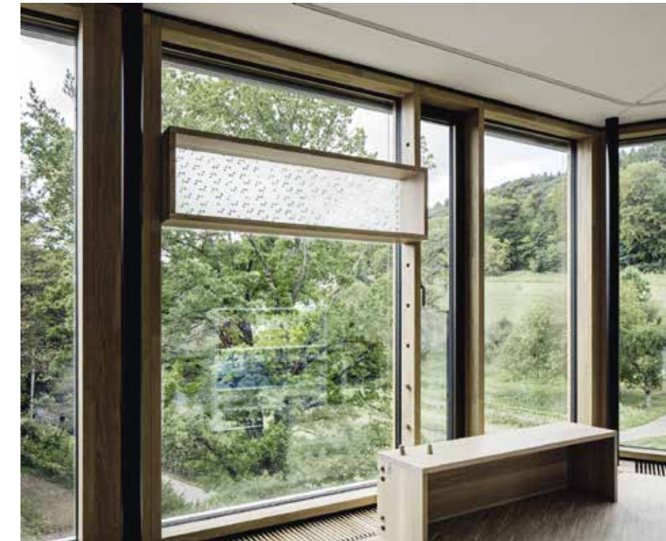
Das Design der Fassade resultiert aus dem Wunsch nach viel Tageslicht und einem starken Bezug zum Aussenraum durch geschoss-hohe Verglasung mit gleichzeitiger Nutzungsmöglichkeit der Fassadenflächen.
