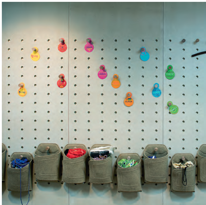
Bild 8. Garderobensystem mit Filztaschen (Fotos/Grafiken: bauzeit architekten GmbH)
