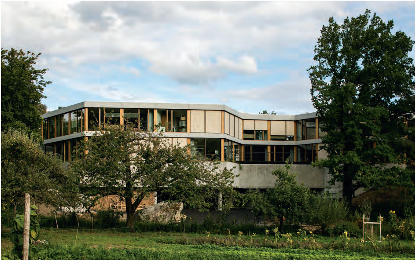
Bild 1. Haus A der Berufsbildenden Schulen I (BBS I), Wolfsburg: Mit seiner eigenen Architektur setzt das neue Schulgebäude einen markanten Akzent am Schachtweg
